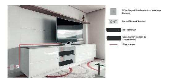
Lors de l'installation, vous convenez avec le technicien de l'emplacement du boîtier optique dans votre domicile. Le câble circule soit de manière apparente (ex: sur le dessus de vos plinthes), soit dans des goulottes. Vous pourrez ensuite procéder à l'installation de vos équipements (box, décodeur TV) et ainsi profiter des avantages de la fibre optique chez vous!
